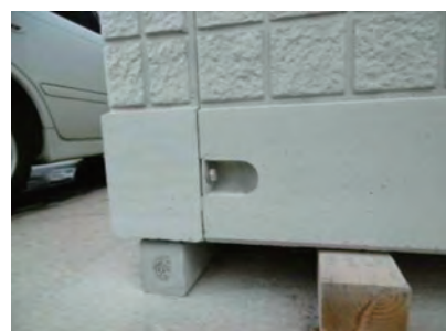
⑥連結部の締め付け(側壁)
