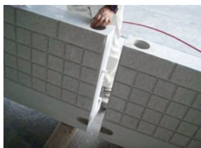
⑤製品の据付
