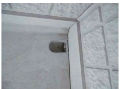
⑦連結部の締め付け(底版)
