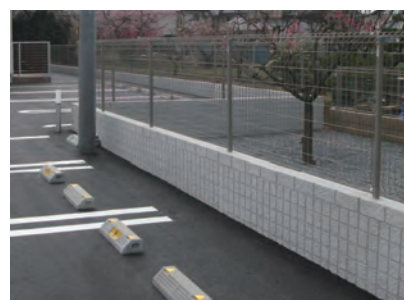
⑨施工完了
