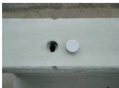
⑧吊り用インサート専用キャップ
