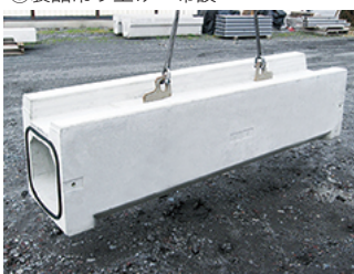
③製品吊り上げ・布設
