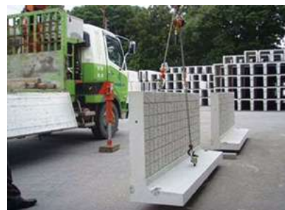
③製品の吊上げ、吊り下ろし (3点吊り、土留めタイプ)
