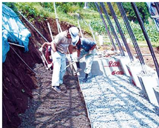
胴込・裏込砕石作業
