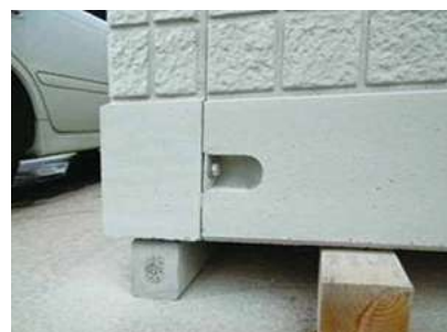
⑥連結部の締め付け(側壁)
