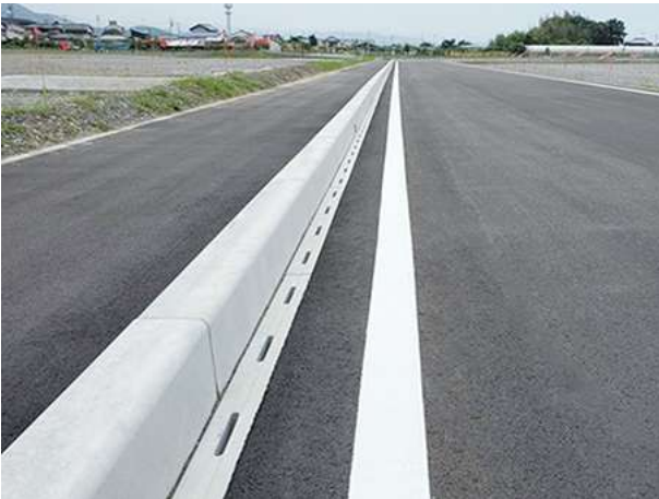
南国日章工業団地(高知県南国市)
