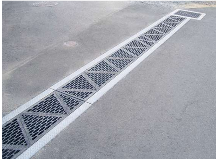
長尺U横断溝天端勾配型
