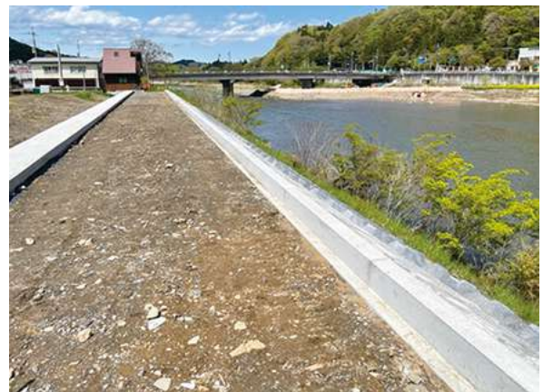
一級河川 久慈川堤防(太子町)
