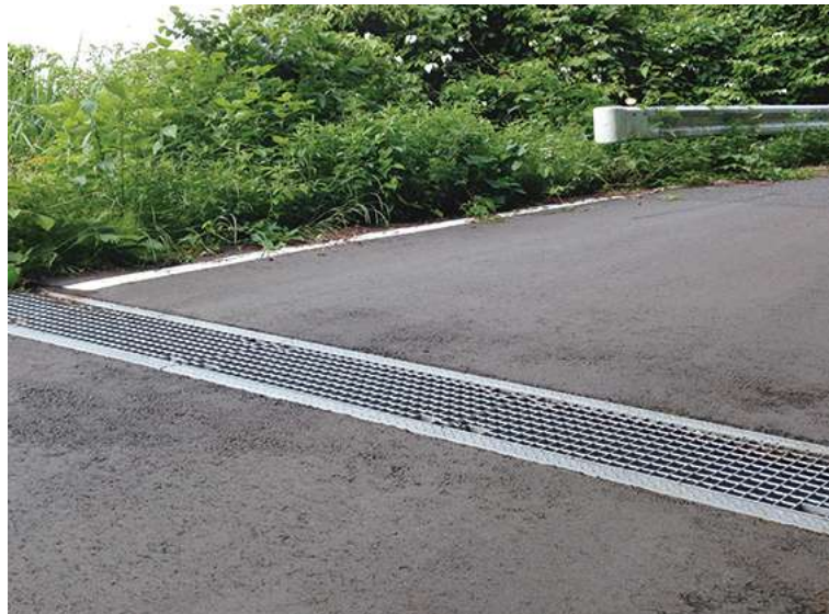
長尺U横断溝天端勾配型
