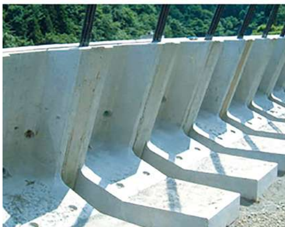
ブロック設置(背面)
