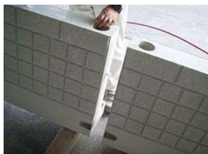
⑤製品の据付
