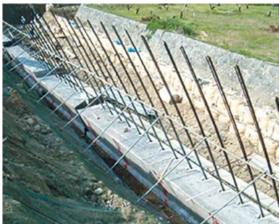
縦貫鉄筋設置
