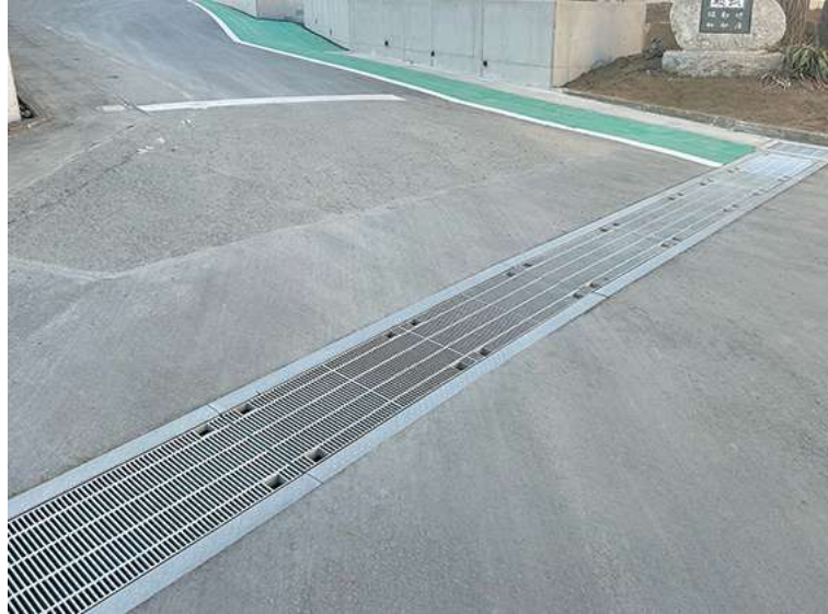
長尺Uトライポット式横断溝
