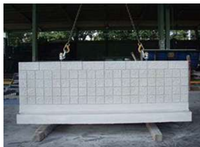
②製品の吊上げ、吊り下ろし (2点吊り、基本タイプ)
