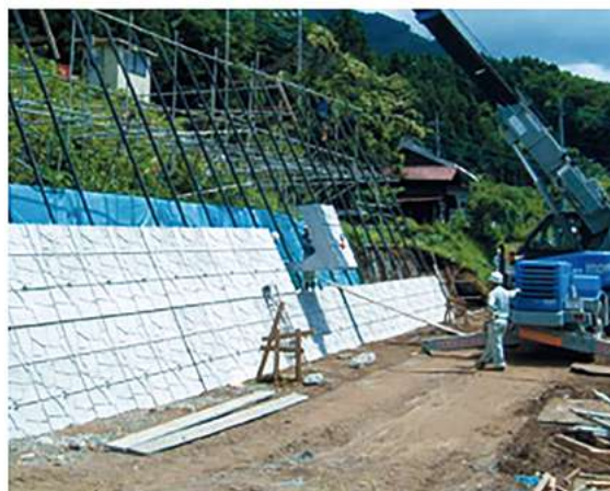
ブロック設置作業
