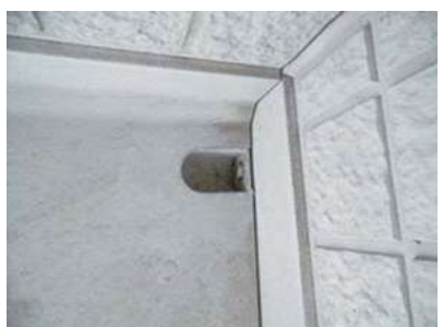
⑦連結部の締め付け(底版)
