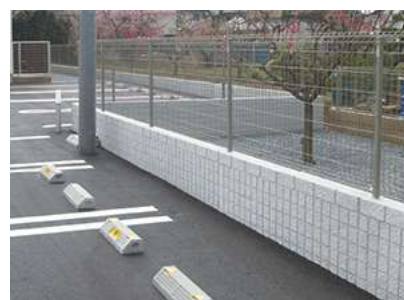
⑨施工完了
