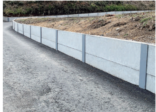
町道8-1056号線(城里町)
