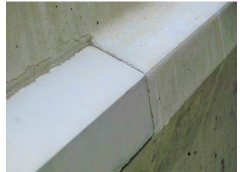
ボンド厚2mmで接着することにより高さが揃います。
